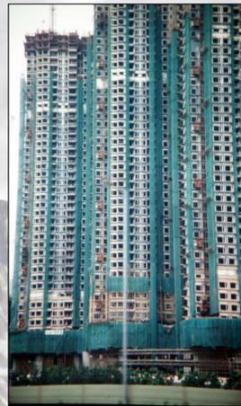
Bau mittels Bambusgerüsten
